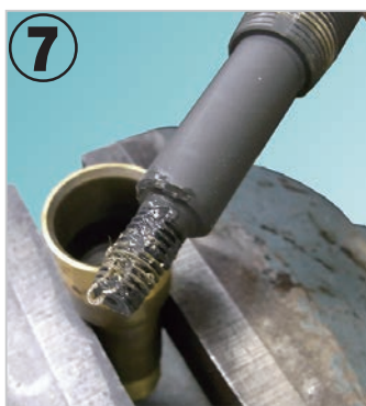
⑦取り外したノズルチューブ ※アタッチメント装着時に先端に少量のグリスを塗布しておくこと作業時に出る切粉を燃焼室への落下防止になります。
